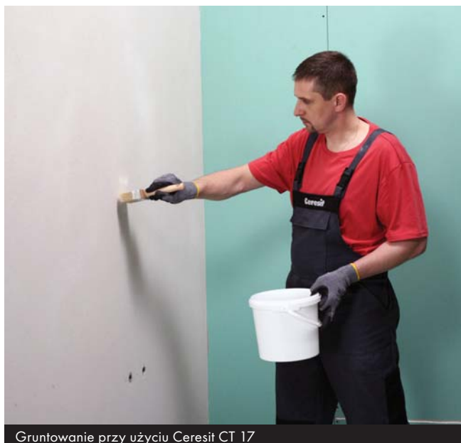
Gruntowanie przy użyciu Ceresit CT 17
