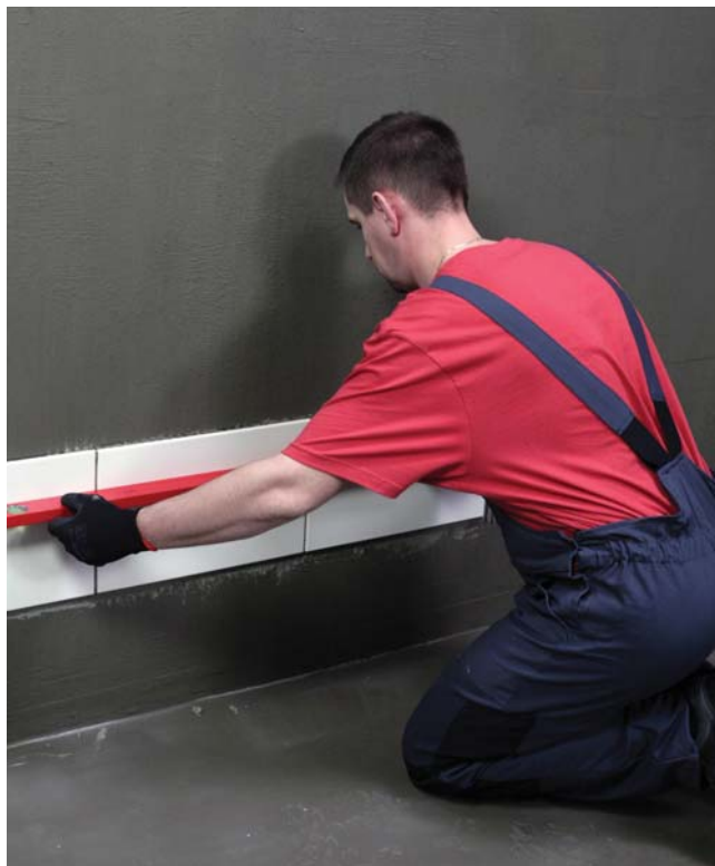
Zaprawa CM 16 umożliwia klejenie płytek bez konieczności stosowania listew startowych
