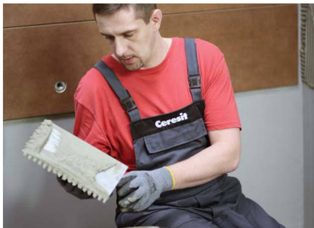
Zaprawę należy rozprowadzać po podłożu pacą o odpowiednio dobranych zębach. Należy stosować zasadę im większy wymiar płytek tym większy wymiar pacy zębatej
