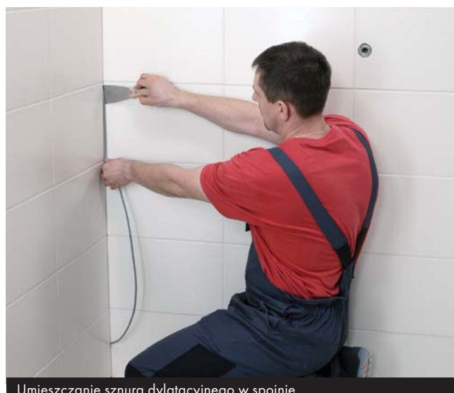
Umieszczanie sznura dylatacyjnego w spoinie
