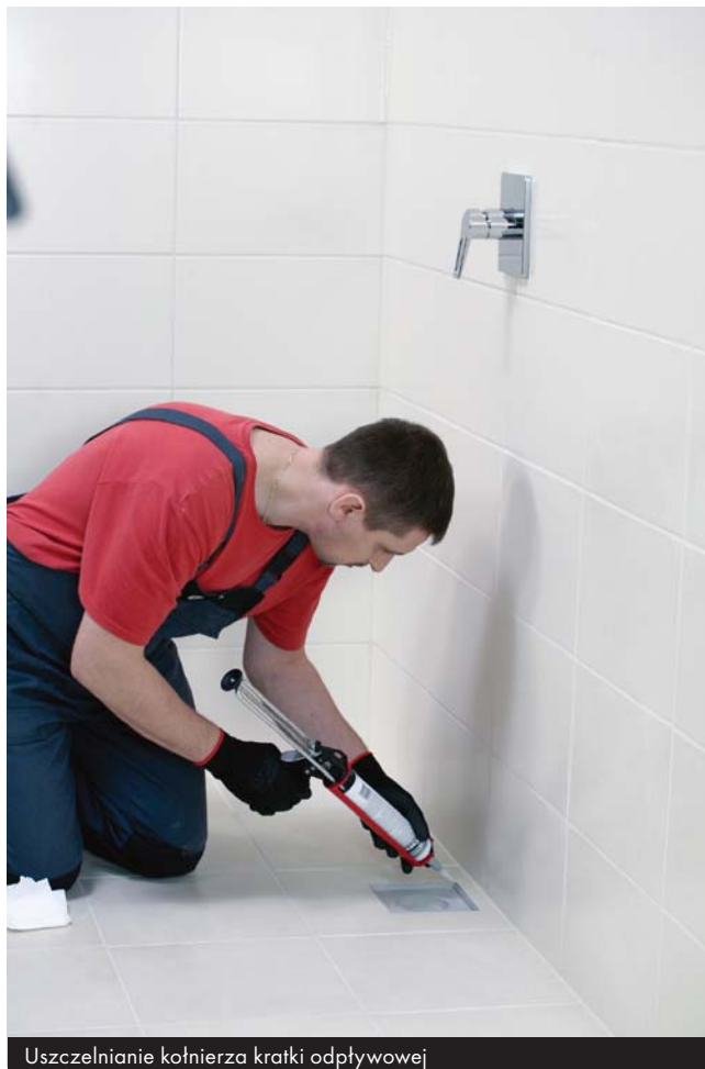
Uszczelnianie kołnierza kratki odpływowej
