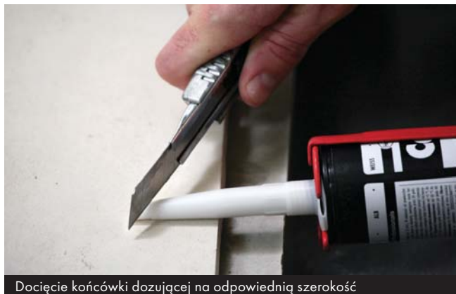
Docięcie końcówki dozującej na odpowiednią szerokość
