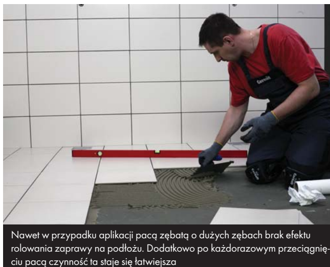
Doskonałe parametry robocze pozwalają na uzyskanie 100% rozptyłu zaprawy CM 22 pod płytką
