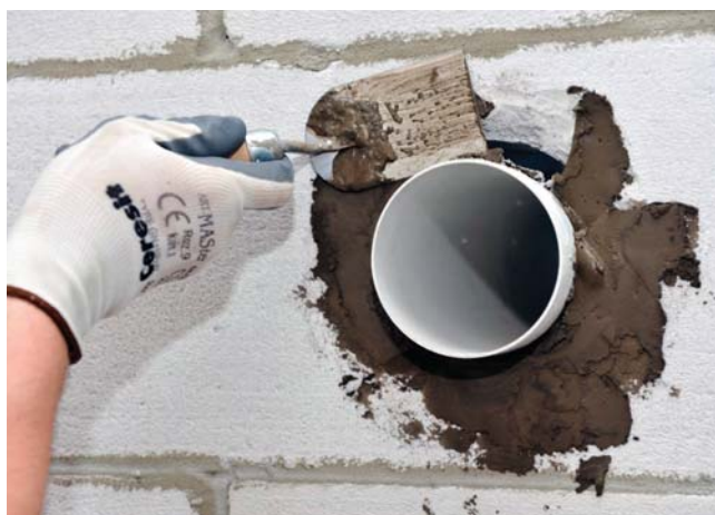
Montaż za pomocą zaprawy CX 5
