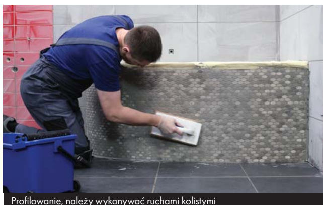
Profilowanie, należy wykonywać ruchami kolistymi
