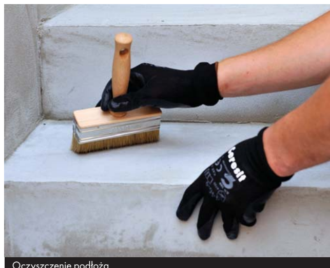
Oczyszczenie podłoża
