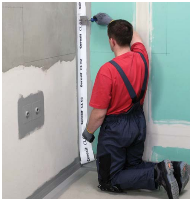
Wklejanie taśmy uszczelniającej CL 62 w narożnikach pionowych.
