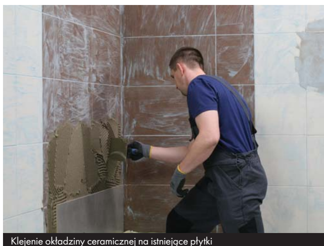
Zwiększona retencja wody w zaprawie CM 22 umożliwia dobranie odpowiedniej konsystencji w zależności od zastosowania
