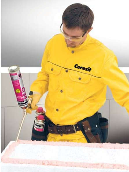
Klejenie płyt styropianowych w złożonych systemach ociepleniowych Ceresit Ceretherm
