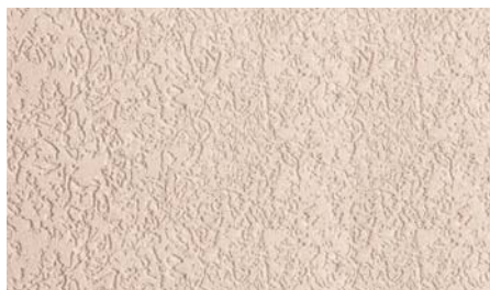
Tynk mineralny o fakturze „kornik” Ceresit CT 35, o uziarnieniu 2.5 mm, otrzymywany przez okrężne zacieranie pacą
