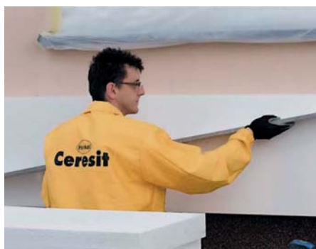
Przyklejanie płyt styropianowych w przypadku „ocieplenia na ocieplenie”
