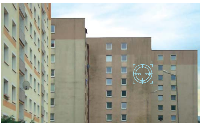
Niezabezpieczony tynk z zanieczyszczeniami biologicznymi.
