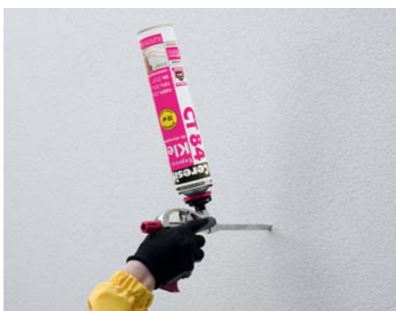
Uzupełnianie kleju w przypadku klawiszowania płyt
