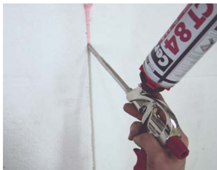
Uzupełnianie szczelin pomiędzy płytami styropianowymi
