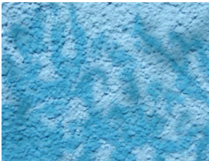
zanieczyszczenia wnikają w strukturę farby
